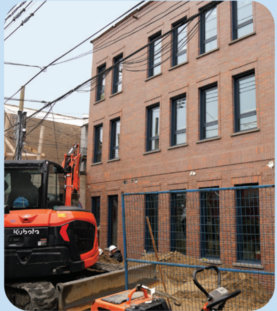
Chantier du Pavillon Monk
